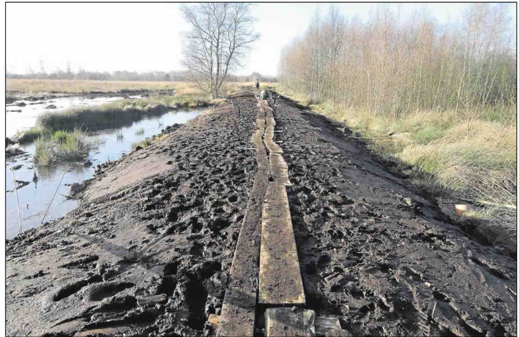
Mitarbeiter vom Naturschutzing Dümmer verlegten Eichenbretter auf einer Länge von ungefähr 100 Metern auf dem Damm. Nun soll dort noch Schreddermaterial ausgebracht werden.
