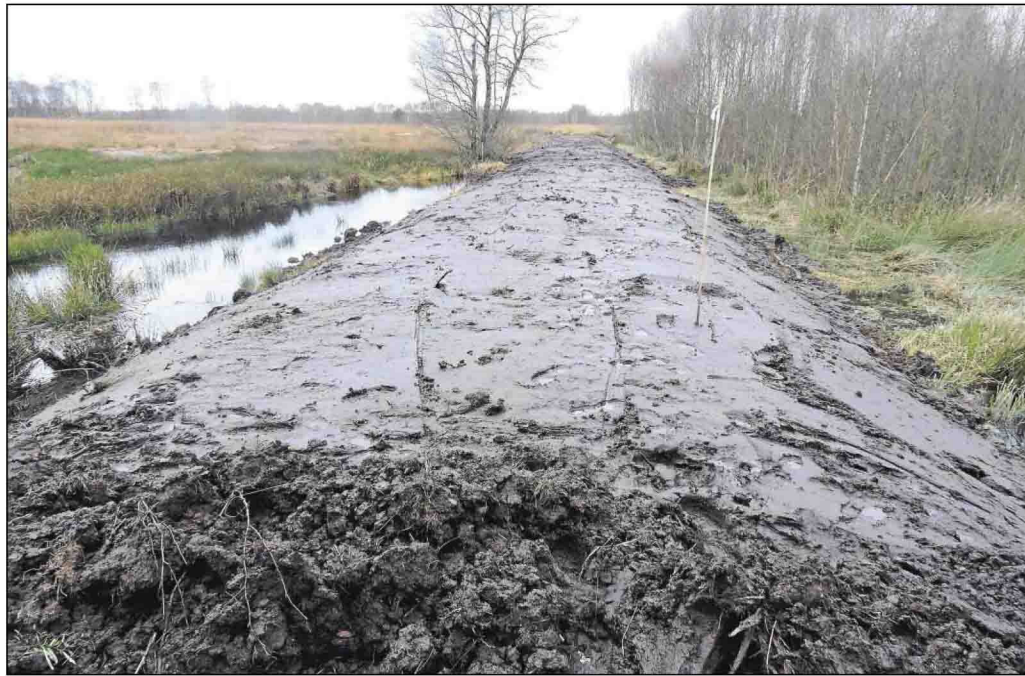
Mit Dämmen aus Torf wird das Regenwasser im Moor zurückgehalten. Frisch aufgeschichtet sind sie zum Begehen zu nass.
